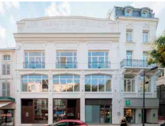
2025 : façade après travaux
