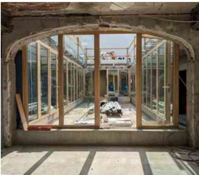
intérieur pendant les travaux
