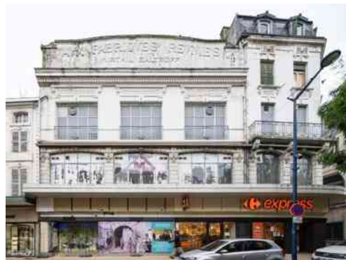
2022 : façade avant travaux
